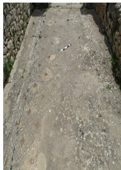
Mosaïque altérée et fissurée
