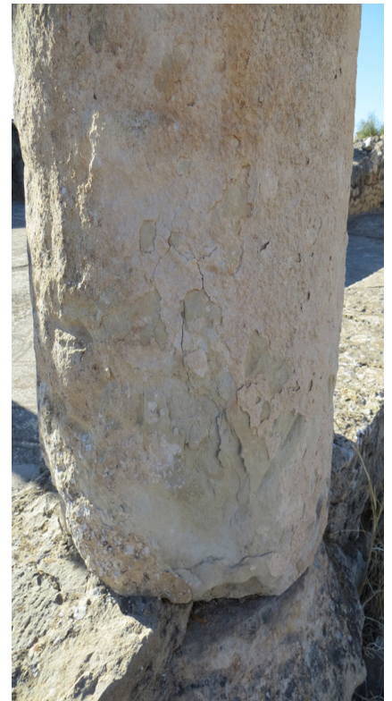
Desquamation en feuillets sur une colonne de péristyle de la maison de Vénus
