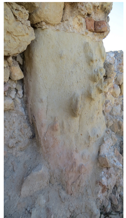
Désagrégation sableuse sur les thermes de la maison de Vénus
